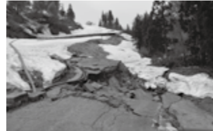
県道及び大原スキー場被災状況▶P. 3
