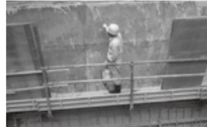
クラックセイバー塗布状況▶P. 7
